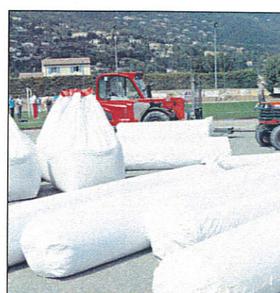
Il a fallu apporter 70 tonnes de sable spécifique de 0,4 à 0,8 mm et 50 tonnes de billes de gomme pour réaliser la sous-couche avant la pose de la pelouse.
