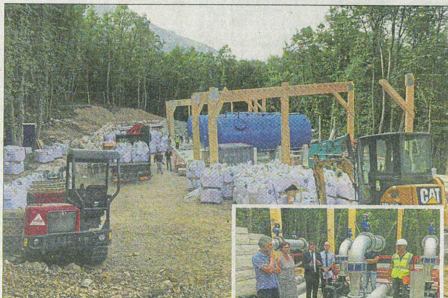
Cinq filtres en acier de 9 tonnes ont été installés. Ils seront ensuite remplis de sable, une étape nécessaire au filtrage de l'eau.
