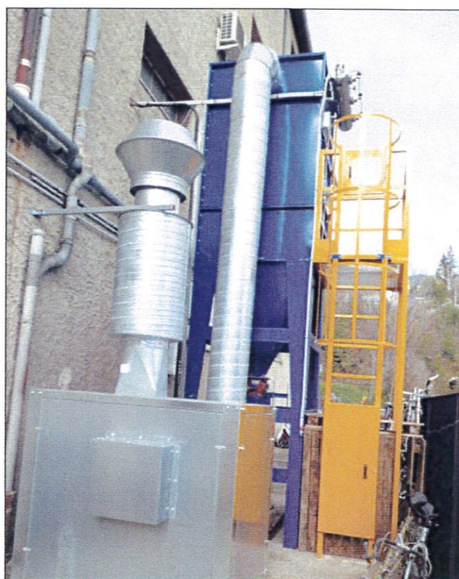
Ci-dessus, le collecteur qui assure filtration et récupération du toner résiduel, des grains essentiellement composé de carbone chargé négativement inoffensif pour l'homme, ils peuvent être nocifs pour l'environnement. A gauche, l'installation du « big bag » étanche qui va réceptionner la poussière de carbone.
