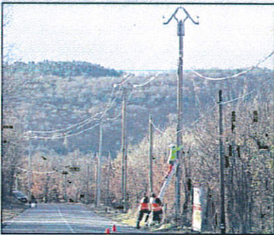
Ce pylône a été haubané et renforcé par les services techniques et les pompiers. (Photo J.Die.)
