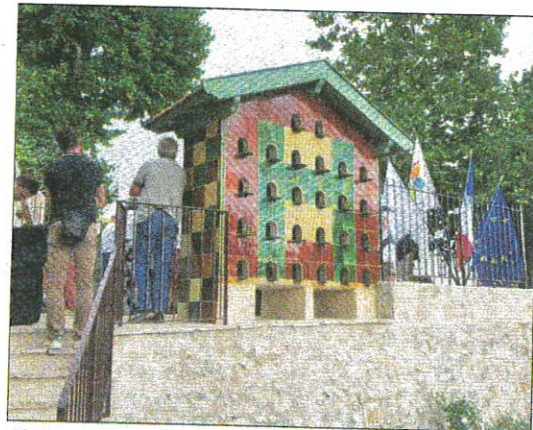
L'édifice est recouvert de carreaux vernissés posés à l'origine pour protéger les volatiles. Leur aspect glissant et sans aspérité interdit l'accès à tout prédateur, rapace, rat et autre renard.
