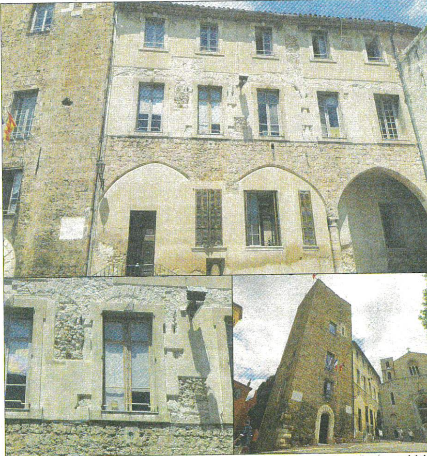
La façade sud de la mairie a subi une opération d'écroûtage partiel dans le cadre d'investigations archéologiques, qui révèle une deuxième galerie couverte au-dessus de la première en rez-de-chaussée. Elle reliait également le palais épiscopal et la tour de l'évêque.
