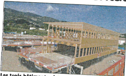
Les trois bâtiments plus petits sont construits en parallèle et en bois, une solution plus rapide, moins coûteuse et respectueuse du développement durable.
