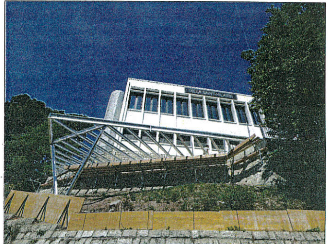
La charpente métallique du belvédère est posée. Du bois composite et un garde-corps la rejoindra bientôt pour conclure le chantier. (Photo V. T.)
