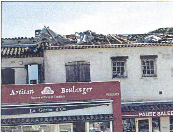
Une bonne partie des tuiles du toit de Chez Rosette a été soufflée par le vent. (Photos J.O.)
