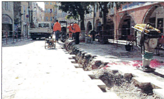
Place aux Aires, les travaux sur le réseau électrique permettront de brancher le système de refroidissement de la patinoire sans faire sauter les plombs de tout le quartier. (Photo M.L.M.)
