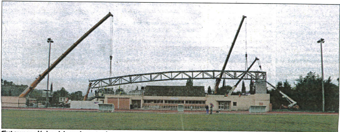
C'est sous une légère pluie que la poutre de 30 tonnes qui compose « l'épine dorsale » de la nouvelle tribune a été posée, hier au stade Perdigon.
