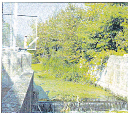
Les martellières, obsolètes et en mauvais fonctionnement ne jouent pas leur rôle d'où les problèmes sur le territoire de La Roquette-sur-Siagne. (Photo J. O.)
