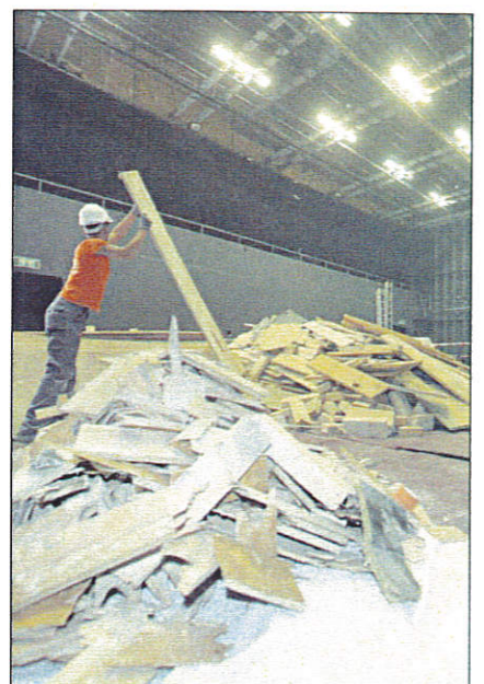
Le coffrage en bois des gradins a entièrement été détruit et a investi la scène du TDG avant d'être évacué.
