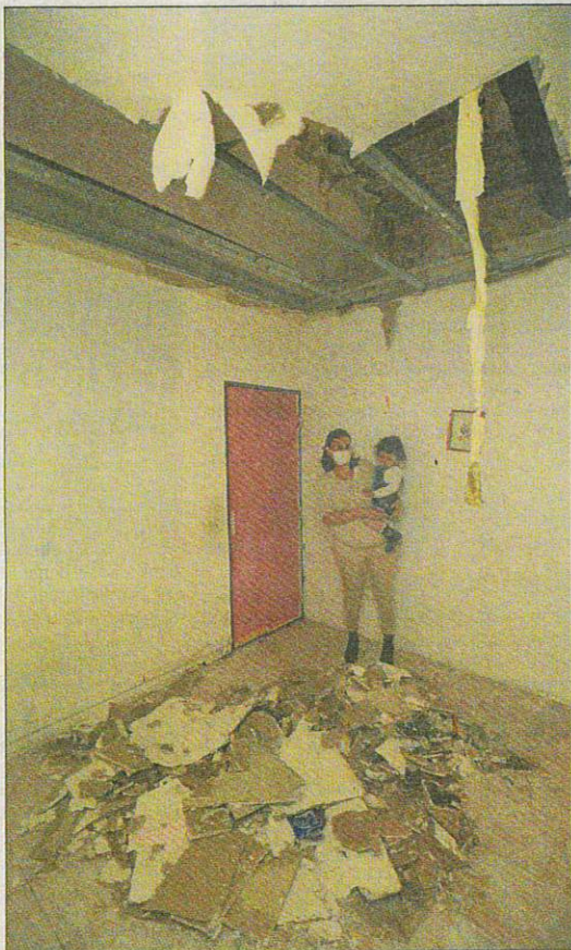
Dans la chambre parentale, une partie du plafond s'est effondrée. Ci-dessous, les toilettes et la porte de la salle de bains, envahies par la moisissure. (Photos Patrice Lapolrie et DR)
