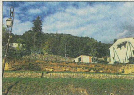
Les talus de la cour de récréation du groupe scolaire se sont effondrés sous le poids des ruissellements.
